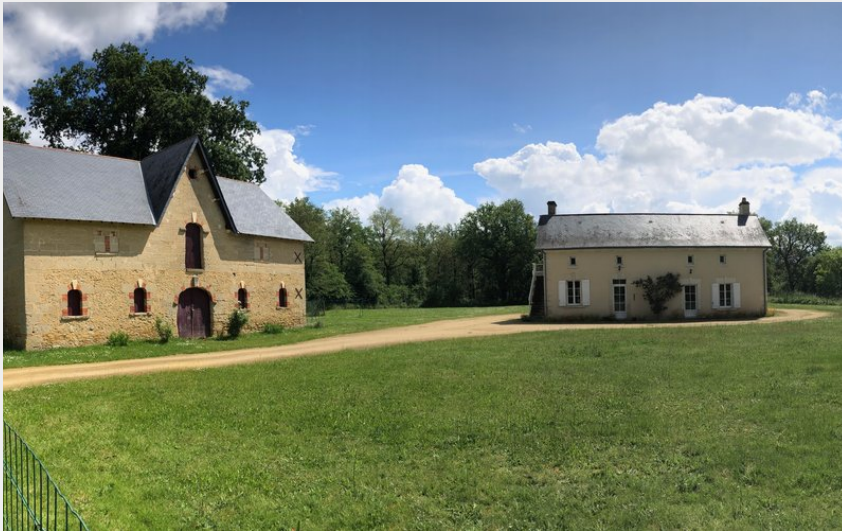
Crédit photo : La maison , sa grange et son jardin clos (florencia de Loture)
