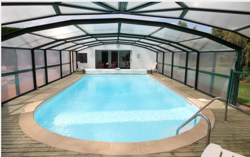
Crédit photo : Piscine chauffée (Sylvette Diguët)
