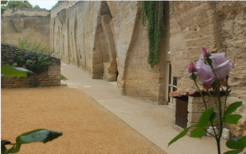
Crédit photo : Centre d'hébergement des Perrières (Pascal Girault)
