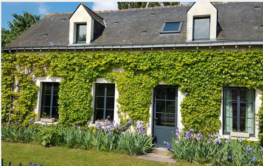
Crédit photo : Façade rue Est (Cécile Coyez)
